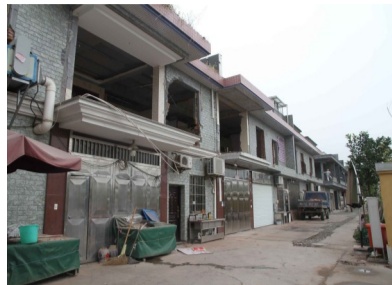
拆除二层附房
